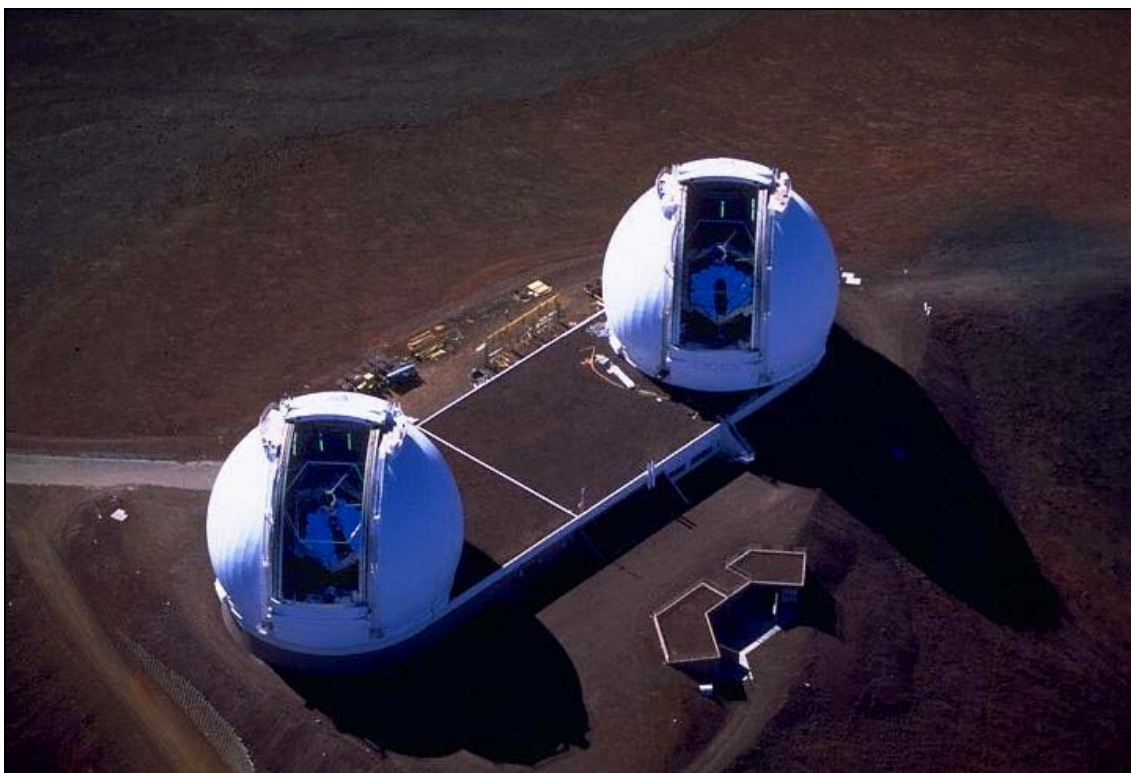
Dva desetimetrové reflektory Keckovy observatoře na Havajských ostrovech slouží jako obří interferometr.
