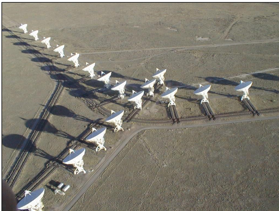
Radioteleskopy na kolejnicích ve tvaru třícípé hvězdy, takže lze nastavit vhodnou vzájemnou vzdálenost (Very Large Array, Socorro, USA).
